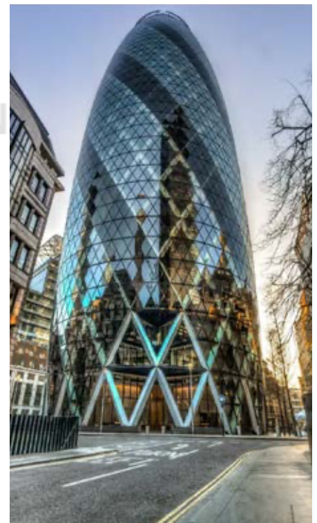
Figura A. En el edificio conocido como “El Pepinillo” creación del arquitecto Norman Foster, podemos ver claramente cómo se empleó intensivamente el triángulo para estructurar y dar forma a esta construcción.
